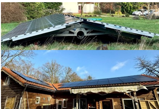
Zonnepanelen in het weiland en op de schuur
