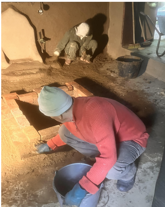
Renovatie van de dhuni
